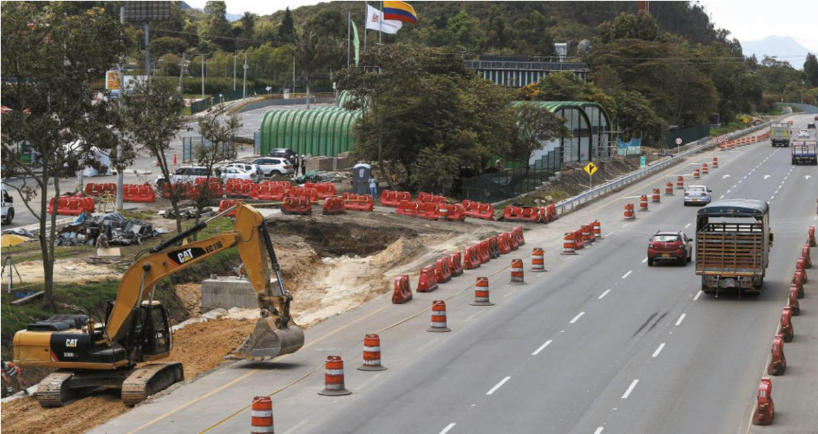
Las obras buscan revertir las pérdidas de la pandemia. En la foto, la Autopista Norte. - Foto: GUILLERMO TORRES REINA
